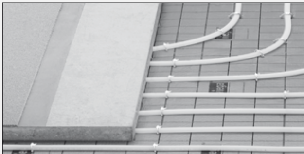
Гибкая система отопления и охлаждения.
