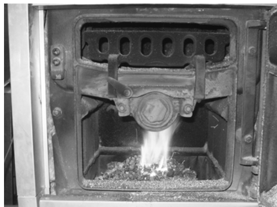
Рис. № 28 Несоответствующая форма пламени
