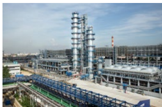
Газпромнефть-МНПЗ, г. Москва
