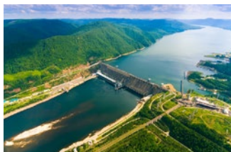
Красноярская ГЭС, г. Дивногорск
