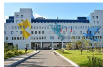
Перинатальный центр, г. Щелково
