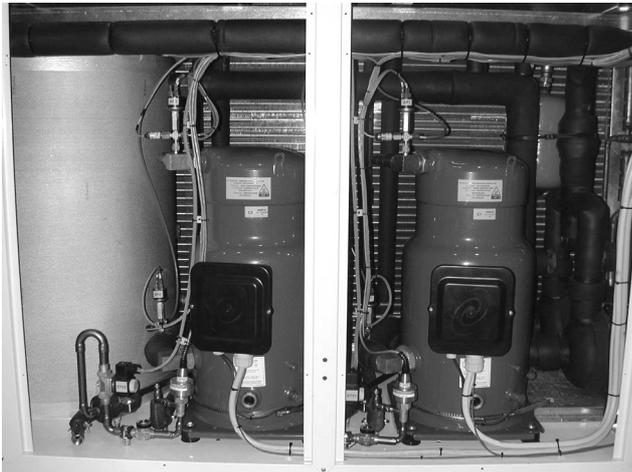
Per prevenire la diluizione dell'olio da parte del refrigerante e la schiumatura dello stesso all'avviamento sono utilizzati dei riscaldatori dell'olio (non previsti sui modelli a condensazione "ON-OFF"); tali dispositivi vengono inseriti automaticamente all'arresto del compressore.
