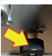
Przywrócić prawidłową wartość ciśnienia, posługując się zaworem napełniania kotła (dla optymalnego działania wartość ciśnienia powinna być zawarta między 0,8 i 1 bar). Po osiągnięciu minimalnej wartości ciśnienia (0,6 bar), działanie kotła jest przywracane.
