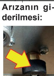
**Arızanın giderilmesi:** Kombi dolum musluğu aracılığıyla basıncı artırarak doğru değere getirin (ideal çalışma için basınç değeri 0,8 ile 1 bar arasında olmalıdır). Minimum basınç değerine (0,6 bar) ulaşıldığında kombi tekrar çalışmaya başlar.
