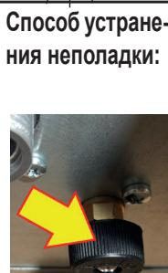
**Способ устранения неполадки:** Восстановить нормальное давление с помощью заливочного крана котла (для оптимальной работы давление должно быть в диапазоне от 0,8 до 1 бара). По достижении минимального значения давления (0,6 бар) работа котла восстанавливается.
