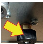
Ripristinare il corretto valore di pressione agendo sul rubinetto di carico caldaia (per un funzionamento ottimale il valore della pressione deve essere compreso fra 0,8 e 1 bar).
