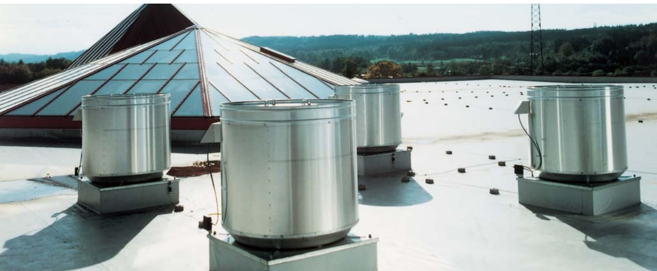
Крышный вентилятор дымоудаления серии BVD 710
