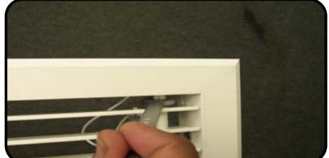
*Примечание: Каркас решетки все еще останется закрепленным к раме посредством предохранительного шнура.*
