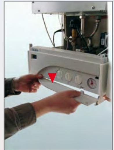
7. Снимаем передний кожух облицовки котла и переднюю крышку эл. панели.
