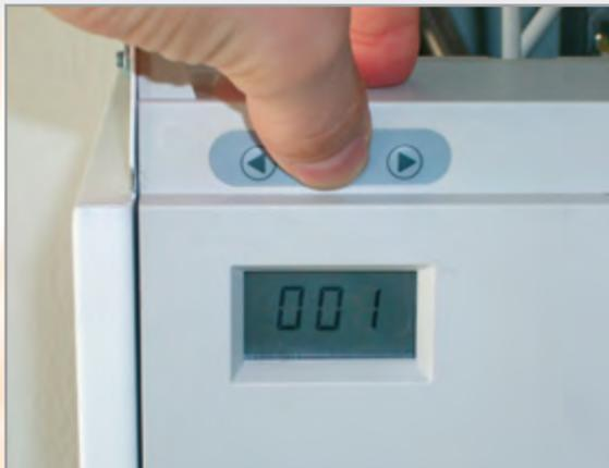
36. Средней кнопкой можно проверить функцию модулятора (в левом крайнем положении рукоятки регулятора отопления котёл горит на минимум, при вращении в правое крайнее положение котёл увеличит мощность на максимум - ограничение параметром №2).
