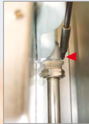
20. Проверяем герметичность всех соединений водяного контура котла.
