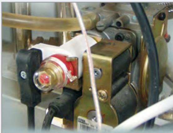
**30.** Отсоединяем коннектор модулятора и снимаем крышку модулятора
