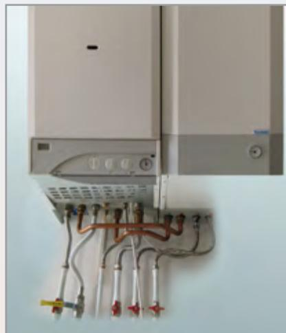
1. Проверяем условия инсталляции котла (размещение, наличие стабилизатора, вывод устья трубы за пределы объекта и т.д.) - условия могли измениться из-за действий пользователя по сравнению с состоянием при запуске котла!
