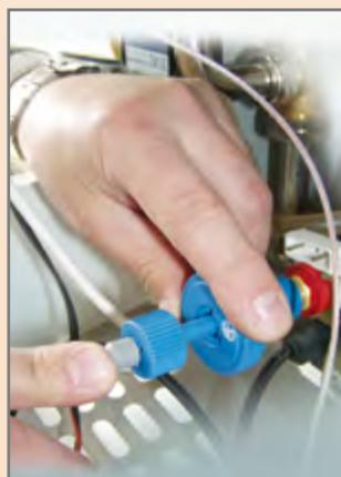
33. С помощью регулировочного ключа при необходимости корректируем давление газа на соплах (точный порядок регулировки описан в инструкции по вводу котла в эксплуатацию).
