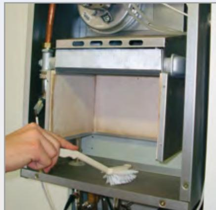
13. С помощью щетки и пылесоса удаляем все загрязнения из камеры сгорания - действуем от верхней части в направлении вниз. После этого проверяем проходимость и чистоту прерывателя тяги. Для версии ТУРБО дополнительно удаляем загрязнения из закрывающей камеры. Задержавшиеся на нижней крышке закрывающейся камеры загрязнения отсасываем пылесосом.
