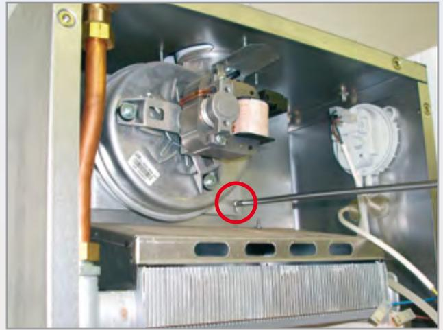
**12.3** С помощью малой щетки очищаем отдельные пластины крыльчатки.
