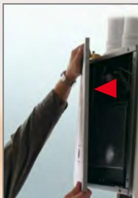
9. Отворачиваем винты крепления камеры сгорания и снимаем кожух на себя (обратите внимание и не повредите изоляцию камеры сгорания).
