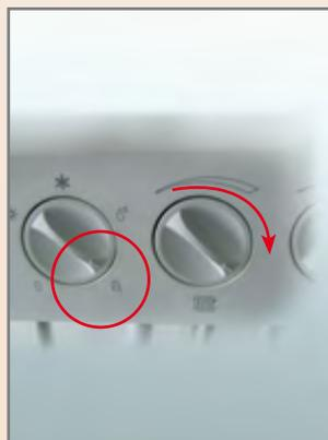
**32.** Нажатием стержня проверяем минимальное и максимальное давление газа на соплах котла - по графику для соответствующего котла. После отсоединения кабеля от модулятора, котёл горит с минимальной мощностью. Нажатием серого стержня на регулировочном ключе увеличиваем мощность котла до максимума!
