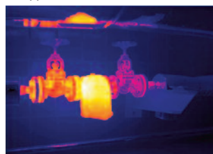
Проверка функциональности паропроводящих труб
