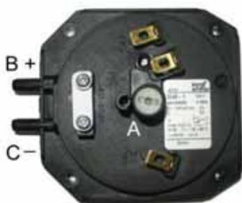
„А” – винт регулирования давления
