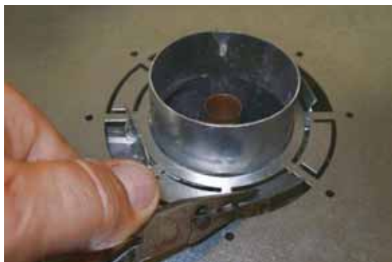
Рис. 6.2.3.2. Способ отгибания ограничителей протока воздуха (крылышек) – вид сверху газового аппарата
