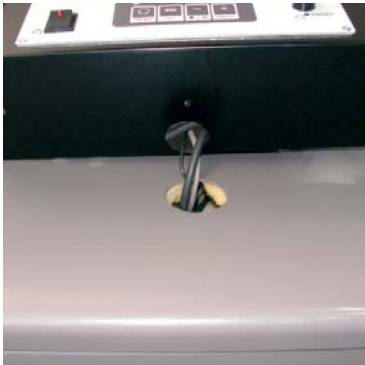
Рис. 13.13: Отверстие прохода покрытия
