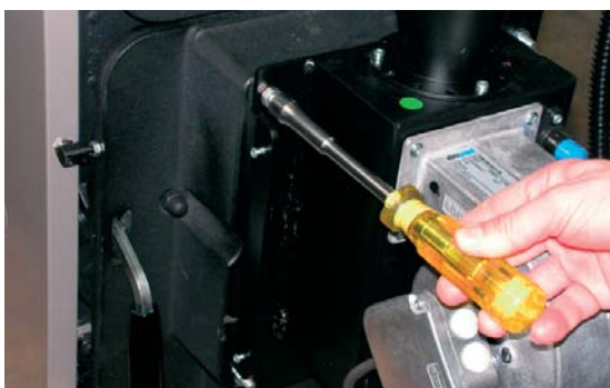
Рис. 13.11: Установка горелки
