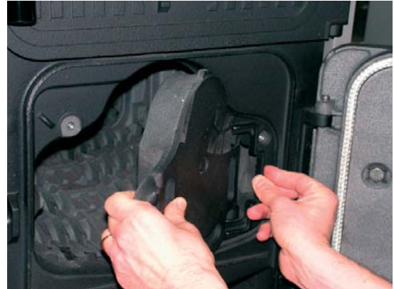
Снятие решетки. 13.1: Демонтаж решетки
