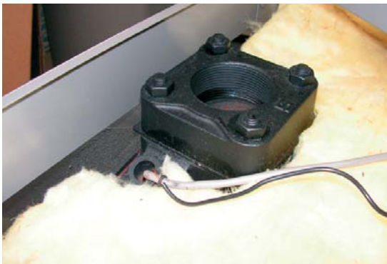
Рис. 13.16: Ввод датчиков в кожух
