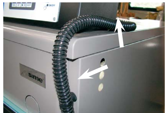
Рис. 13.19: Направляющие хомутики кабеля
