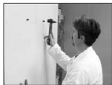
Заверните винты или шурупы, подходящие для крепления агрегата.
