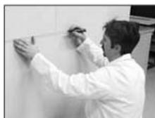
Отметьте места монтажных отверстий.
