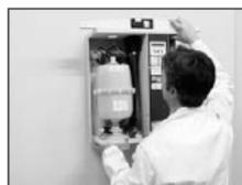
Повесьте корпус. Выровняйте его по спиртовому уровню и закрутите все винты до упора.
