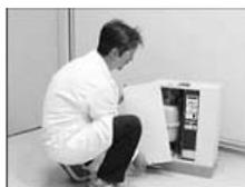
Необходимо обеспечить свободное пространство вокруг агрегата: от 1 м до 1,20 м между полом и увлажнителем, 1,25 м перед и 0,60 м справа для обеспечения легкого доступа при проведении технического обслуживания.
