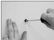
Закрутите винты, оставив около 10 мм, для того чтобы повесить корпус.
