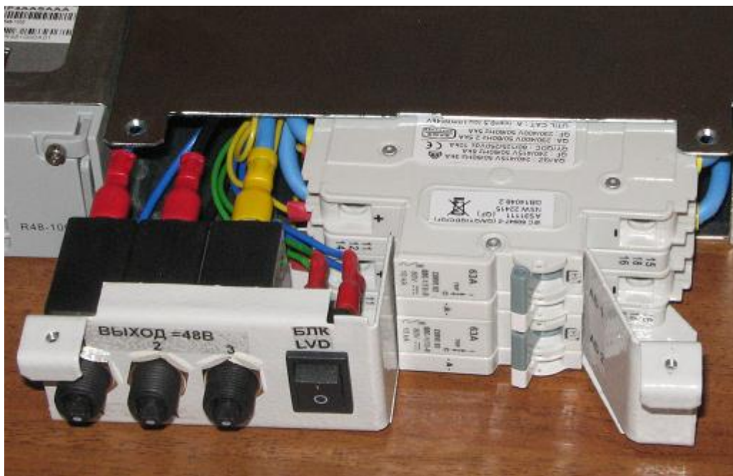
Рисунок 4.3 – Автоматические выключатели
