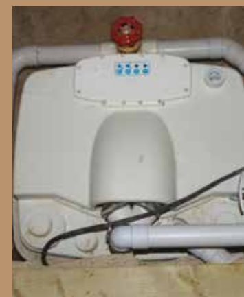
Насосная станция SANICUBIC® 2 Pro установлена в подвале
