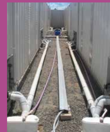
SANIBEST® Pro перекачивает сточные воды в специальный резервуар
