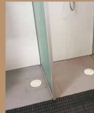
Душевые в подвальном помещении
