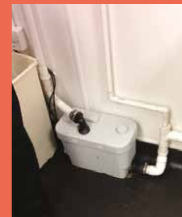
Насос SANISPEED® установлен в подвальном помещении
