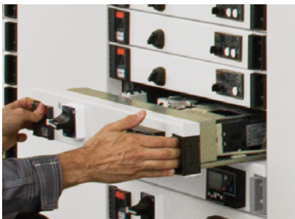
Рис. E32. РУ с выдвигаемыми функциональными блоками
