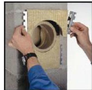
1. Для правильного выбора размера «А», измерьте внешний диаметр подсоединяемого элемента тройника.
