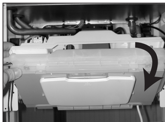
2. Faire basculer le boîtier électrique de la chaudière.
