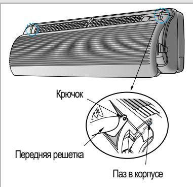
**Чтобы получать наилучшие результаты при эксплуатации вашего кондиционера, вы должны регулярно чистить его для удаления пыли, скапливающейся на воздушном фильтре.**
