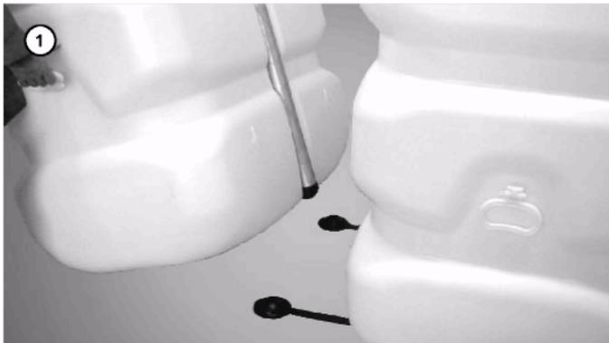
Установите резервуары рядом друг с другом; измерьте расстояние между центрами резервуаров
