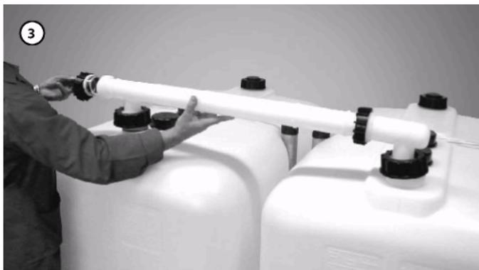
Установите на первый штуцер вместе со вставной погружной трубкой.
