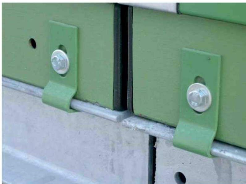
Рис. 2.16. Крепление секций к стальной раме
