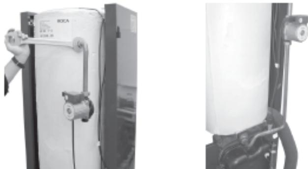
Соединить с помощью патрубка бойлер ГВС и теплообменник котла
