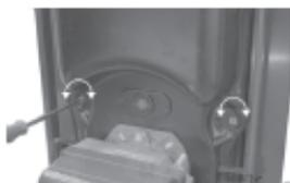
Отвинтите два винта фиксирующие переднюю дверь теплообменника.
