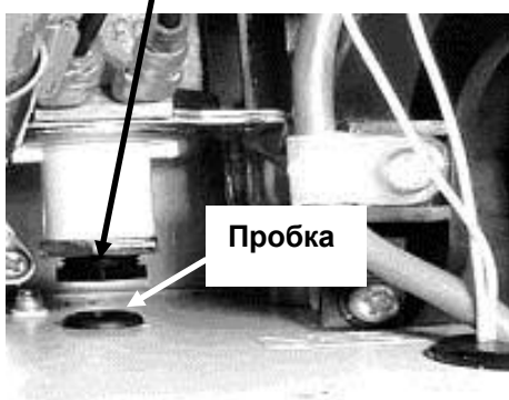
Регулятор минимального давления газа
