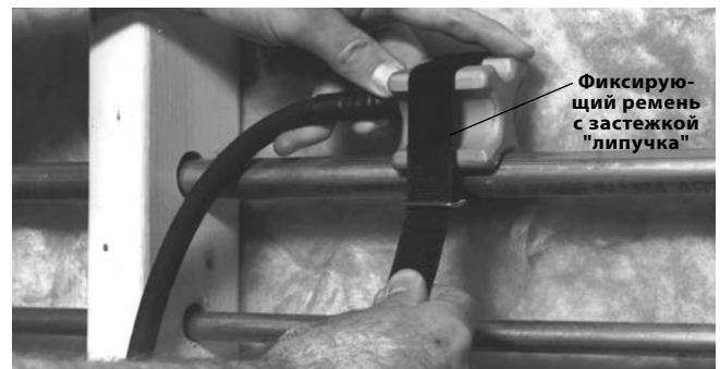
Рис. 5 – Прикрепление замораживающей головки с помощью фиксирующего ремня с застежкой "липучка"
