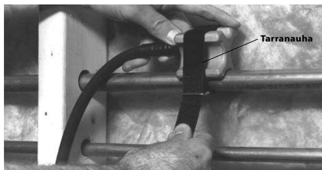
Kuva 5 – Jäädytyspäiden kiinnitys tarranauhalla
