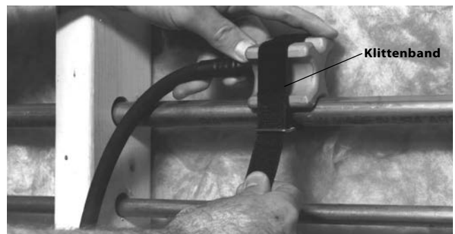
Figuur 5 – Vrieskop bevestigen met klittenband
