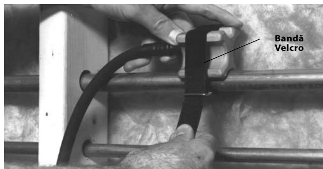
Figura 5 – Aplicarea capetelor de înghețare cu bandă Velcro
