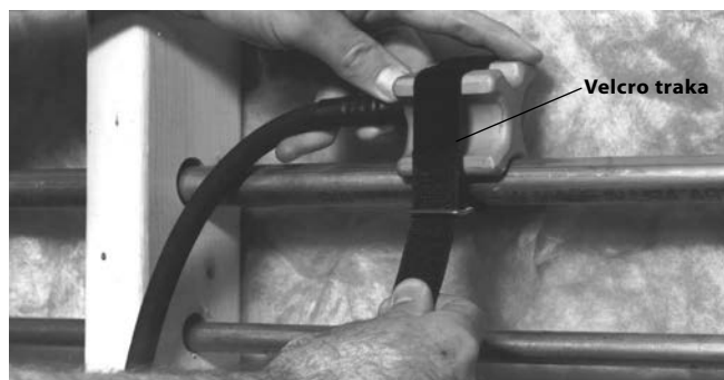
Slika 5 – Primjena glava za zamrzavanje s Velcro trakom
