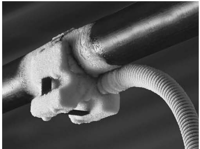
Figur 9 – Fryshuvud fryst vid röret
