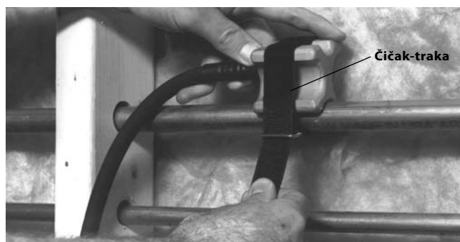
Slika 5 – Pričvršćivanje glava za zamrzavanje čičak-trakom
