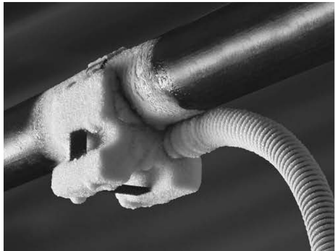
Figur 9 – Frysehode frosset til rør
