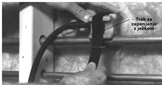
Slika 5 – Namestitev zamrzovalne glave s trakom za zapenjanje z ježkom
