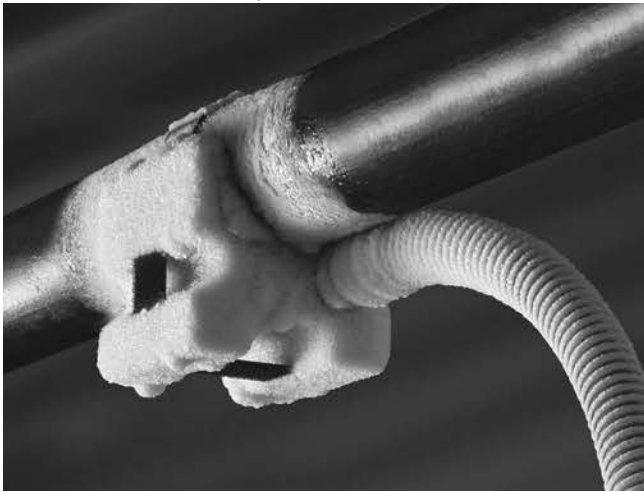
Figuur 9 – Vrieskop vastgevroren aan leiding
