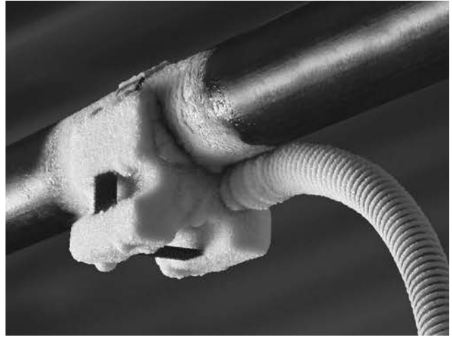
Kuva 9 – Putken jäädystetty jäädyslaitteella
