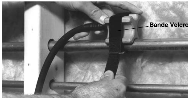
Figure 5 – Montage d'une tête de congélation à l'aide d'une bande Velcro
