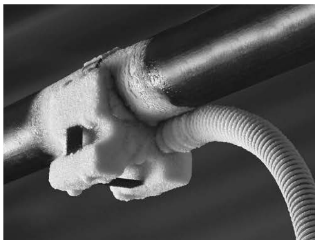
Obrázok 9 – Zmrazovacia hlava primrznutá k potrubiu
