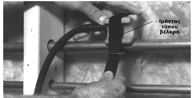
Εικόνα 5 – Τοποθέτηση ψυκτικής κεφαλής με ιμάντα τύπου βέλκρο
