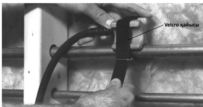
5-сурет – Velcro қайысы бар мұздату басын пайдалану
