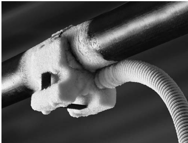
Figura 9 – Cabezal congelado contra la cañería
