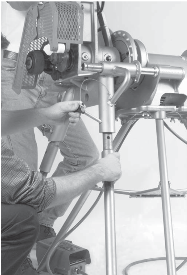
Рисунок 5 – Монтаж ножек к основанию желобонакатчика
