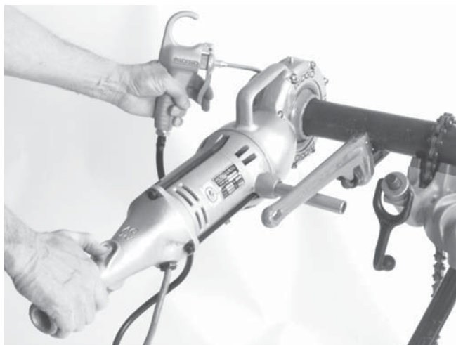
Рисунок 6 – Нарезание резьбы с помощью трубного ключа в качестве струбины-фиксатора
