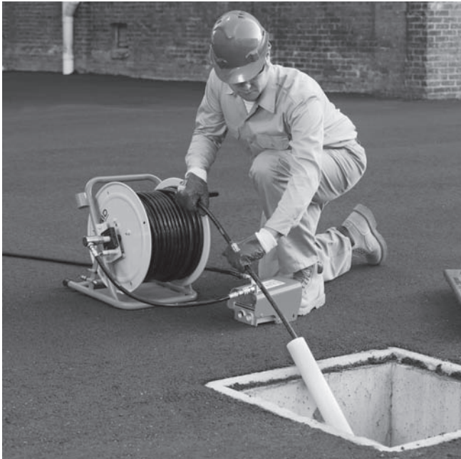
Kuva 10 – Viemäriaukon jatkaminen käyttöpisteeseen
