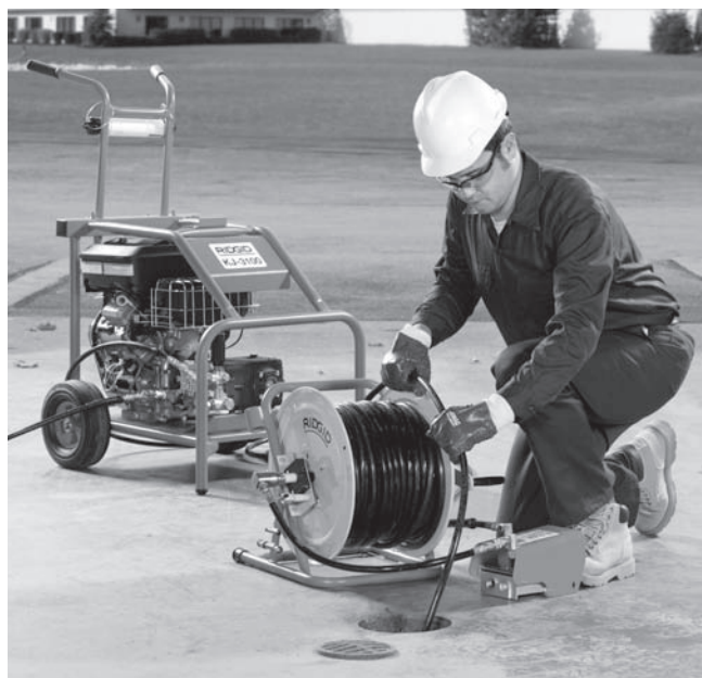
Figura 14 – Posição de Funcionamento Adequada
