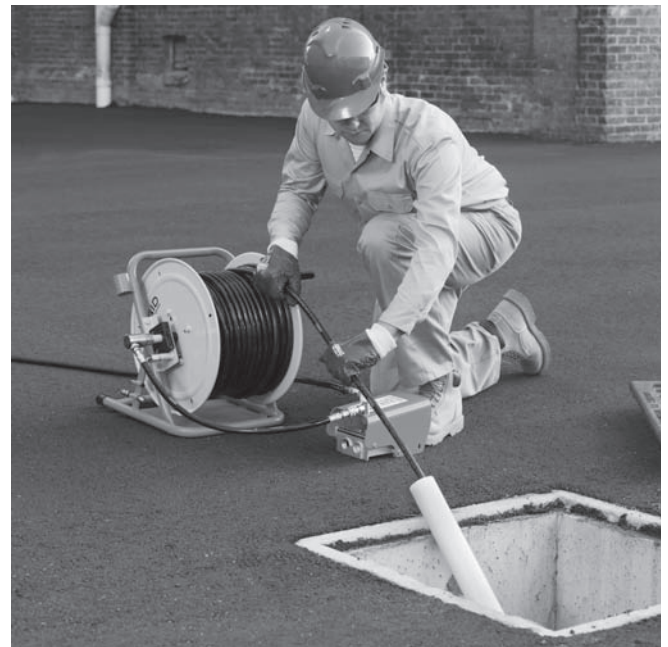
Εικόνα 10 – Προέκταση του στομίου του αγωγού μέχρι το σημείο εργασίας
