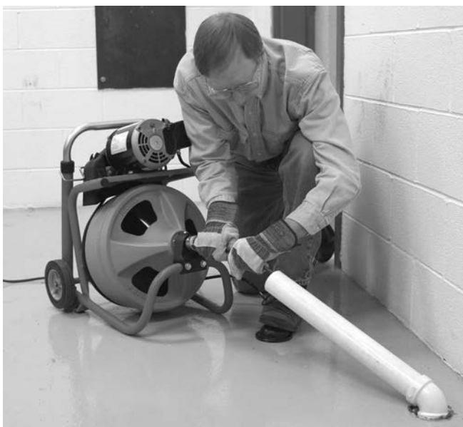
Kuva 9 – Esimerkki viemäriaukon pidentämisestä 2' päähän
