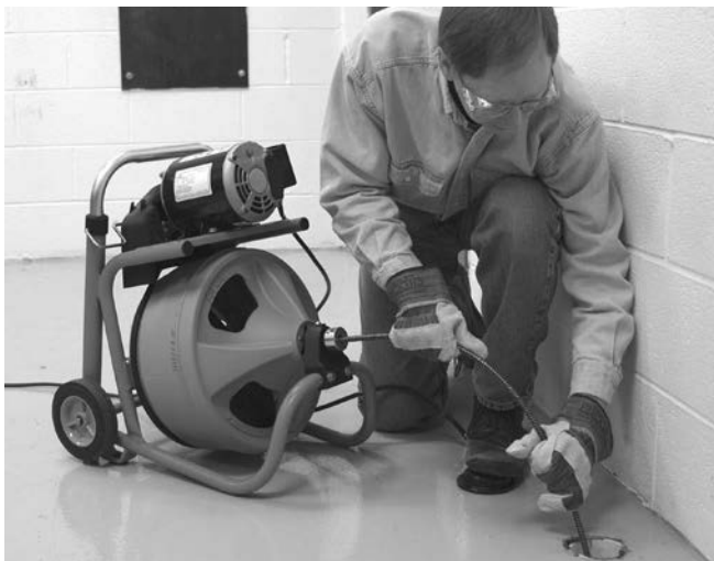
Figur 12 – I driftläge med manuell kabelframmatning
