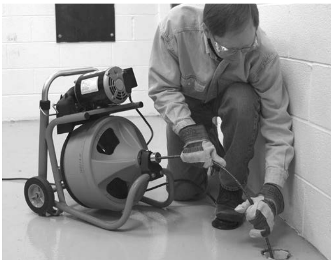
Slika 12 – Ipoložaju rada, ručno uvlačenje sajle
