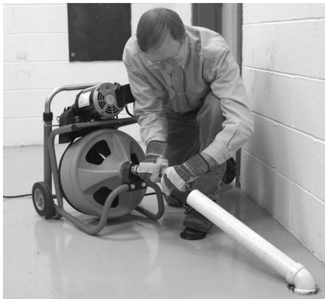
Figura 9 – Exemplo de extensão da tubagem até 2' da abertura da tubagem
