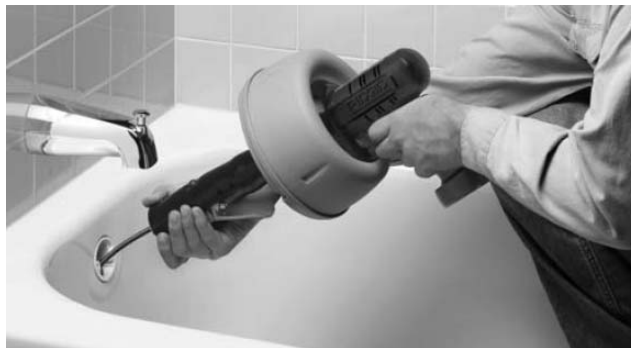
Figura 5 – Manter a Distância Entre a Abertura da Descarga e o Nariz da Pistola até 15,2 cm ou menos
