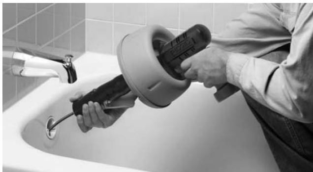
5. ábra – A lefolyónyílás és csőtisztító pisztoly orra között 6" vagy kevesebb távolság legyen.
