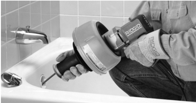
Obrázok č. 9 – Zatláčanie kábla do potrubia odtoku
