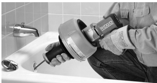
Εικόνα 9 - Ωθήστε το σπιράλ μέσα στον αγωγό αποχέτευσης
