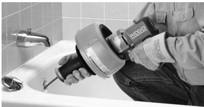
Abbildung 9 – Spirale in den Abfluss schieben
