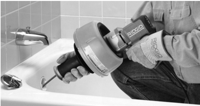
Figuur 9 – Duw veer in afvoerleiding
