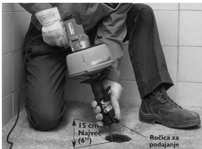
Slika 10 – Podajanje kabela s sistemom AUTOFEED
