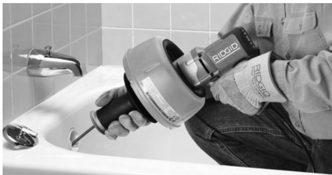
Figur 9 – Skyv kabelen ned i avløpsrøret
