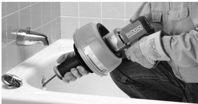
Obrázek 9 - Zasunujte kabel dolů do odpadového potrubí
