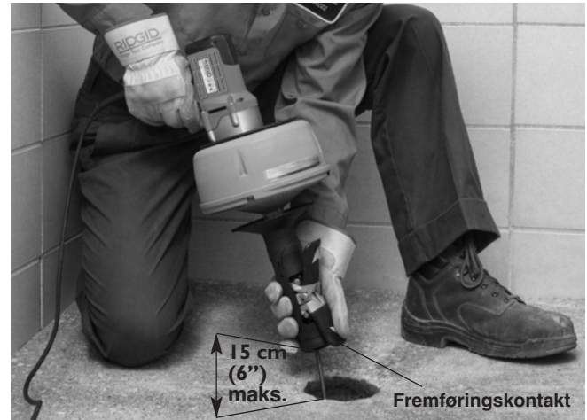
Figur 10 – Fremføring af spiralen med AUTOFEED
