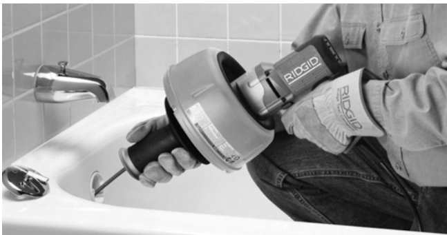
Figura 9 – Empurrar o cabo dentro da tubagem
