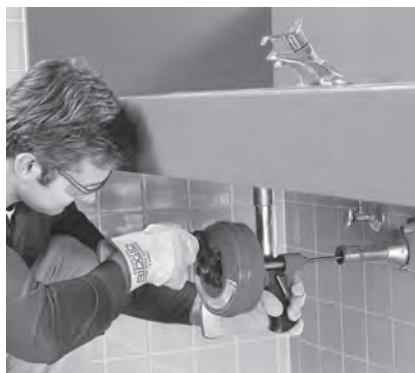
Rysunek 8 – Ręczna obsługa przepychacza Power-Spin
