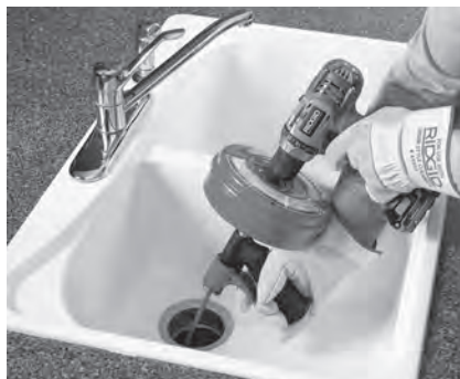
Obrázek 8A – Power-Spin poháněný bateriovou vrtačkou
