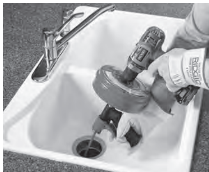
Εικόνα 8Α – Χρήση του Power-Spin με τρυπάνι μπαταρίας
