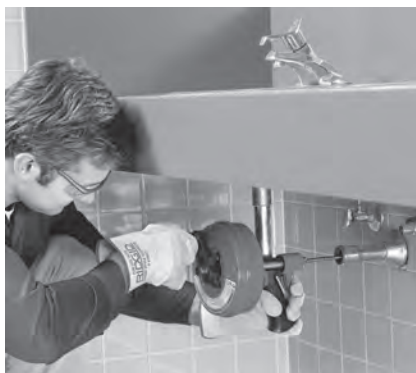
Εικόνα 8 – Χρήση του Power-Spin χειροκίνητα
