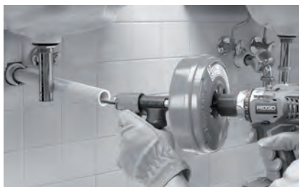
Rysunek 7 – Przykład przedłużenia odpływu na odległość do 4 cali (100 mm) od otworu odpływu
