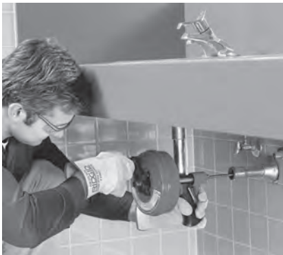
Рис. 8 – Использование Power-Spin вручную
