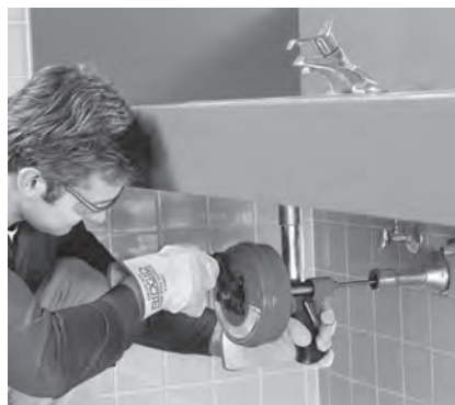
Figuur 8 – Manueel gebruik van de Power-Spin
