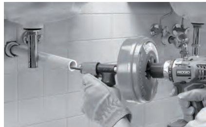
Slika 7 – Primer produženog odvoda u granicama od 4" (100 mm) otvora odvoda
