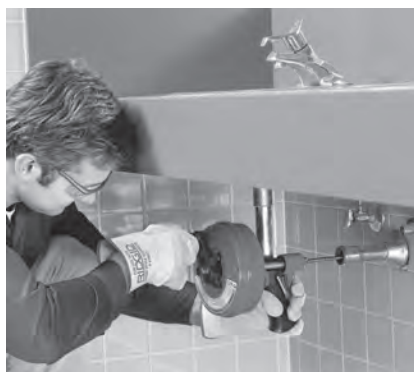
Figura 8 – Power-Spin utilizat manual
