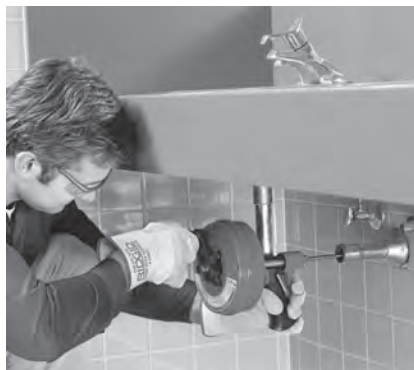
Obrázek 8 – Power-Spin používaný ručně
