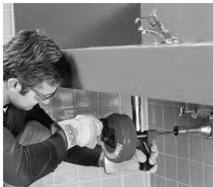
Figure 8 – Utilisation manuelle du Power-Spin
