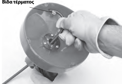
Εικόνα 9 – Τοποθέτηση απόληξης του σπιδάλ μέσα στη διάταξη συγκράτησης
