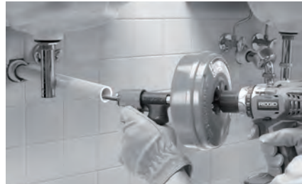
Kuva 7 – Esimerkki viemäriaukon pidentämisestä 100 mm:n päähän
