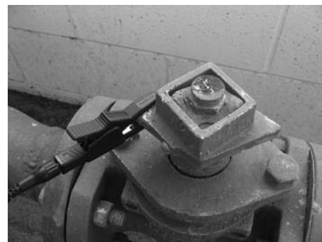
Rysunek 7: Przyłączanie nadajnika ST-305 do linii
