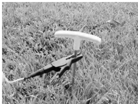
Figura 8: Conexión del cable a la estaca de tierra
