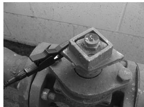
Figuur 9: voorbeeld van aansluiting op een gasleiding
