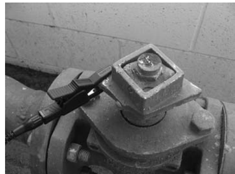
Figura 9: Exemplo de Ligação a uma Conduta de Gás
