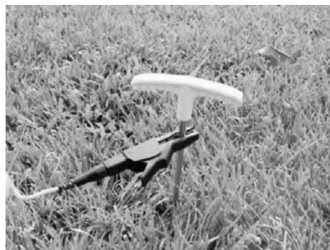
Рис. 8: Подсоединение провода к заземляющему штырю
