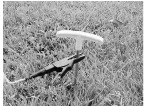
Abbildung 8: Befestigen der Zuleitung am Erdungsstab
