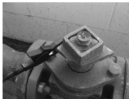
Rysunek 9: Przykładowe podłączenie do linii gazowej
