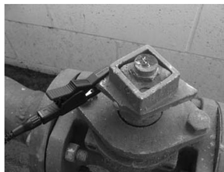
Рис. 9: Пример подсоединения к газовой магистрали
