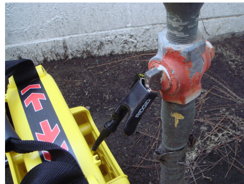
Рисунок 7 – Подводящий провод, подсоединенный к определяемому проводнику
