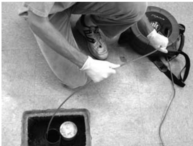
Obrázok 28 – Správna technika pri navíjaní kábla naspäť na bubon
