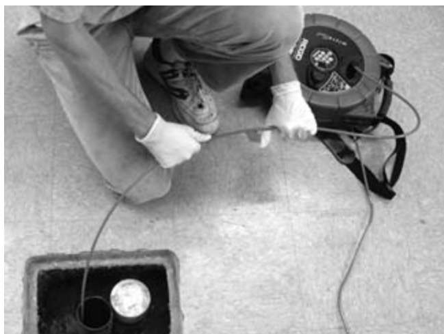
Slika 29 – Če pustite, da se kabel zvije, lahko pride med potiskanjem v boben do prepogibanja kabla
