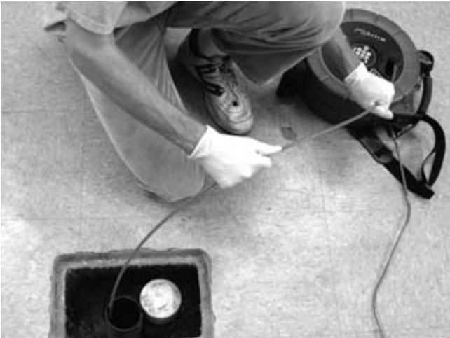
Figura 28 – Método apropiado para devolver el cable al tambor
