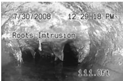
Abbildung 25 – Display mit Folientext, Zeit und Entfernung (Entfernung vom Systemnullpunkt aus gemessen)
