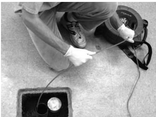
Figur 28 – Korrekt teknik til at skubbe kablet ind i tromlen igen
