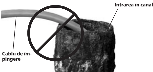
Figura 23 – Evitați trasul cablului la unghiuri ascuțite
