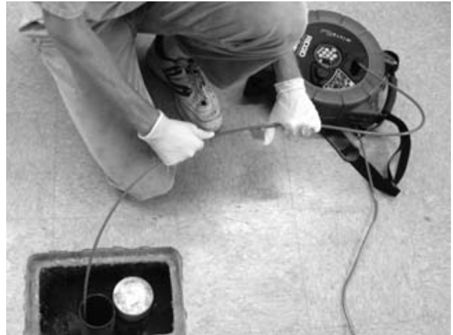
Kuva 29 – Kaapelin päästäminen silmukalle voi aiheuttaa sykkyyriitä, kun sitä syötetään rummulle
