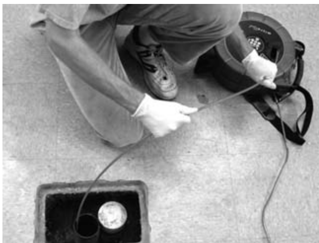
Slika 28 – Prikladna tehnika za guranje kabela natrag u bubanj
