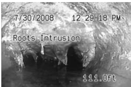
Figura 25 – Display en la pantalla muestra diapositiva superpuesta con texto, fecha, hora y distancia (medida desde el punto cero del sistema)
