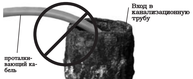
Рис. 23 – Не следует вытягивать кабель по острым кромкам
