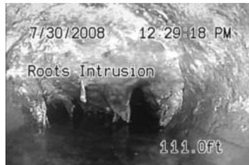
Figura 25 – Ecran de afișaj pentru text de diapozitiv, cu indicarea orei și distanței (distanța măsurată de la punctul zero al sistemului)
