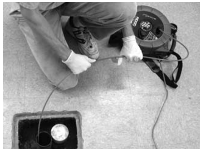
Slika 29 – Omogućavanje kabl da se savije u petlju može presaviti kabl dok ga gurate u bubanj
