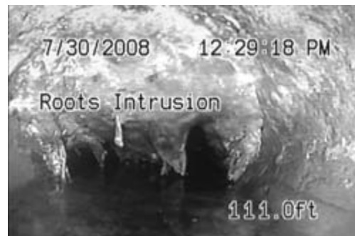
Figure 25 – Écran indiquant l'annotation sur diapo, l'heure et la distance parcourue (distance parcourue depuis le point zéro du système)
