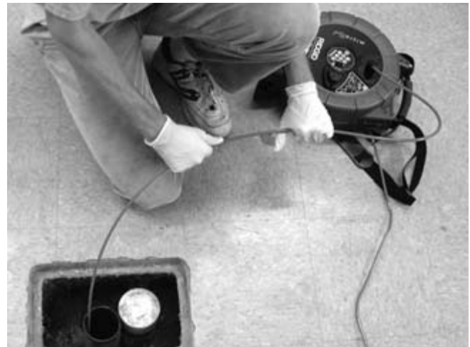
Εικόνα 29 – Αν τραβάτε πολύ καλώδιο, μπορεί να τσακίσει καθώς το σπρώχνετε μέσα στο τύμπανο
