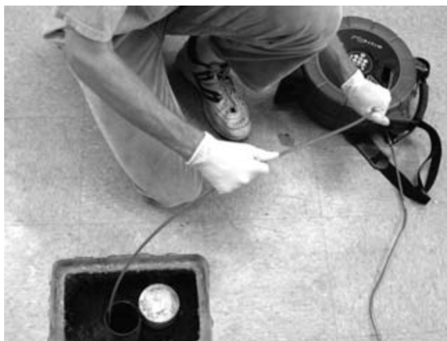
Rysunek 28 – Właściwa metoda wsuwania z powrotem przewodu do bębna
