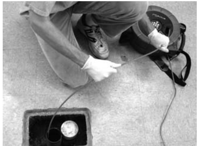
Εικόνα 28 – Η σωστή τεχνική για να ξαναπεράσετε το καλώδιο μέσα στο τύμπανο
