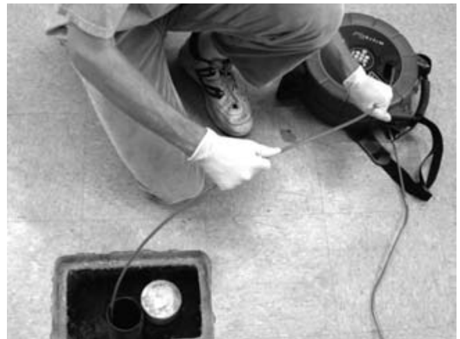
Рис. 28 – Надлежащий метод проталкивания кабеля назад в барабан
