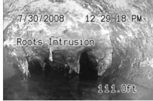
Şekil 25 – Gösterilen Slayt Metni, Saat ve Mesafenin Bulunduğu Ekran (Mesafe sistem sıfır noktasında ölçülmüştür)
