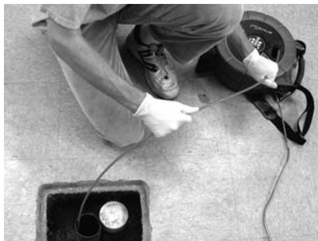
Figura 28 – Tehnica adecvată pentru împingerea cablului în- apoi pe tambur
