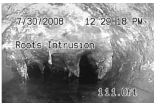
Figura 25 – Exibição no Ecrã com Texto, Hora e Distância em Dispositivo (Distância medida a partir do ponto zero do sistema)
