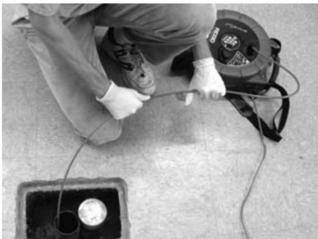
Figur 29 – Lar du kabelen gå i sløyfe, kan det lage knekk på den når du skyver den inn i trommelen
