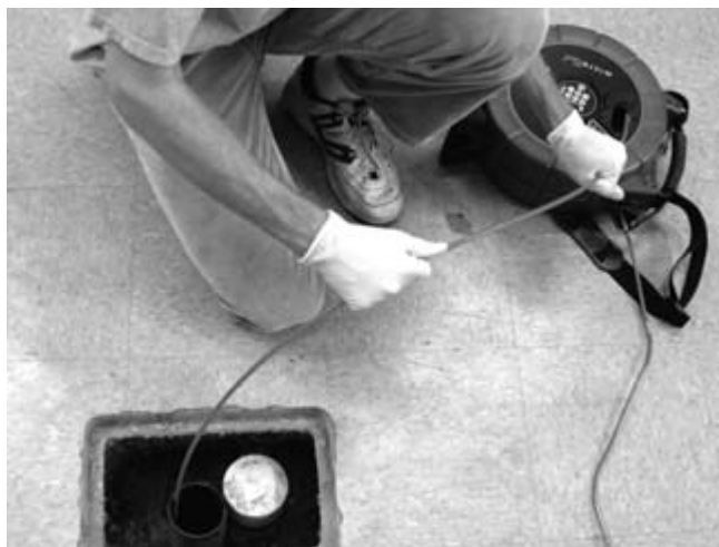
Figur 28 – Rätt teknik för att skjuta tillbaka kabeln i trumman
