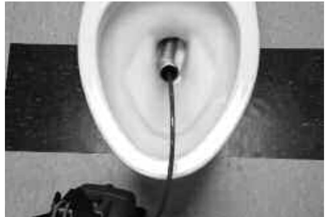
Şekil 25 – Esnek Kılavuz Boru Kullanımı
