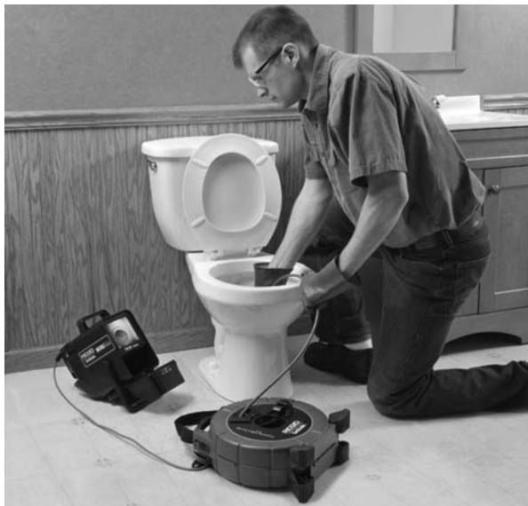
Figuur 15 – Een inspectie verrichten
