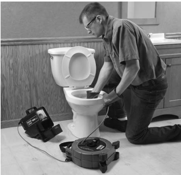
Figura 15 – Una inspección en marcha
