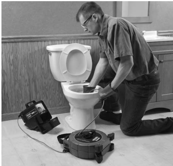
Figure 15 – Inspection en cours
