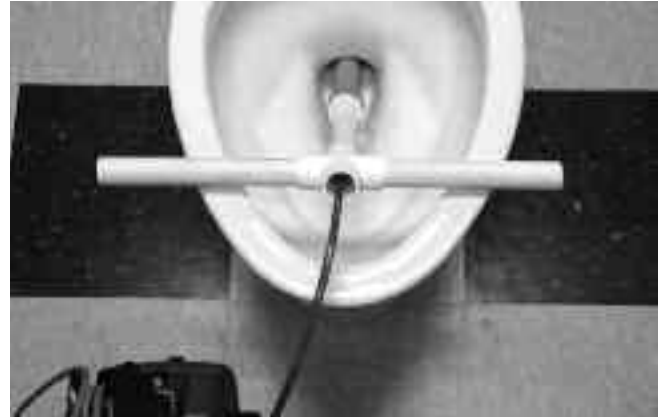
Şekil 24 – PVC Kılavuz Boru Kullanımı
