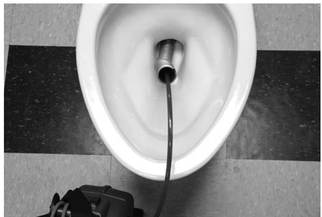
Abbildung 25 – Verwendung eines Führungsschlauchs
