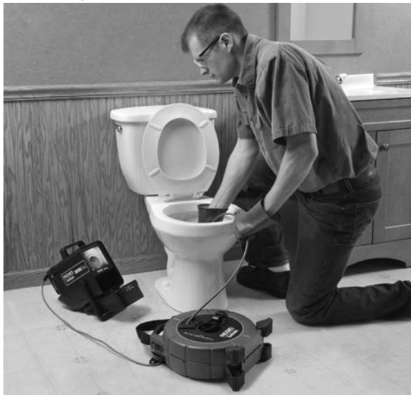
Figur 15 – Utføre en inspeksjon
