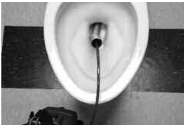
Ilustracja 25 – Używanie elastycznej rurki prowadzącej
