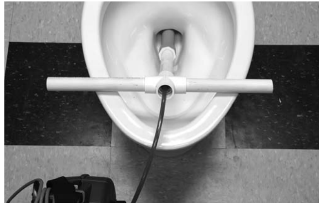
Figura 24 – Empleo de un tubo-guía de PVC
