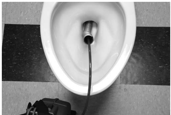
Figur 25 – Brug af et fleksibelt styrerør
