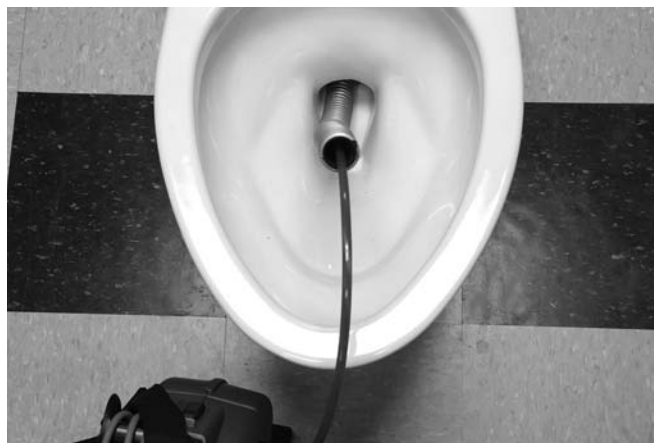
Figura 25 – Utilização de um tubo guia flexível
