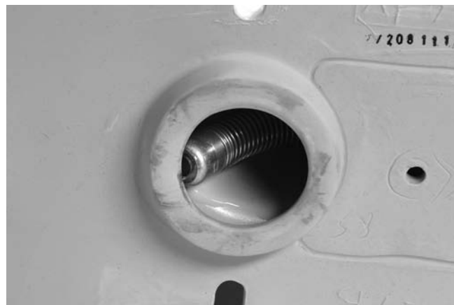
Figuur 20 – Camerakop geblokkeerd in bocht
