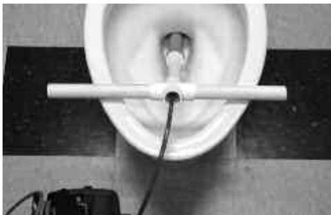
Ilustracja 24 – Używanie rurki prowadzącej z PCV
