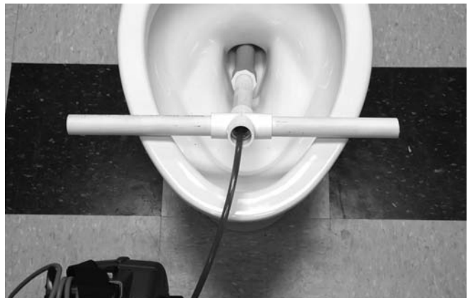
Εικόνα 24 – Χρήση σωλήνα οδηγού PVC
