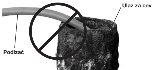
Slika 18 – Izbegavajte povlačenja pod ostrim uglom
