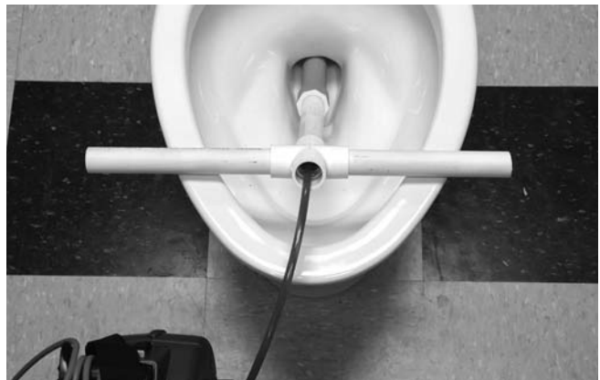
Figur 24 – Brug af et PVC-styrerør
