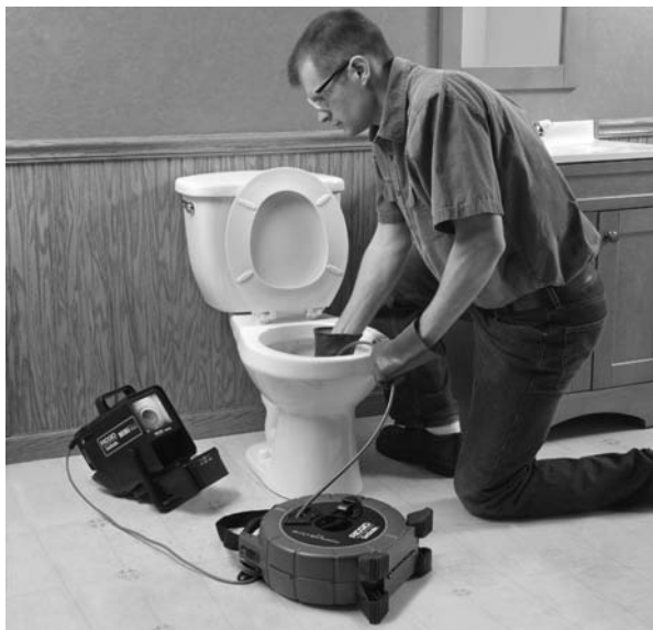
Abbildung 15 – Durchführung einer Inspektion
