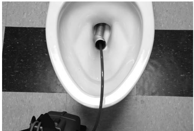
Kuva 25 – joustavan ohjainputken käyttö
