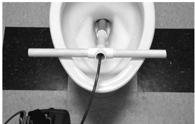
Abbildung 24 – Verwendung eines PVC-Führungsrohrs
