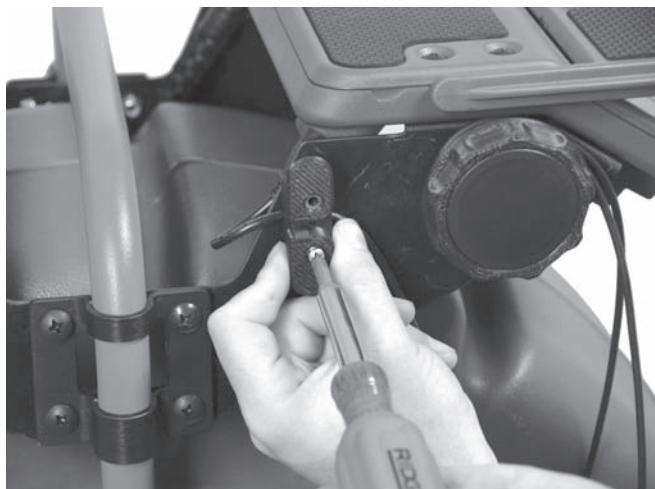
Slika 16 – Montaža namotača gajtana (zapamtite da je USB kabl namotan oko namotača)
