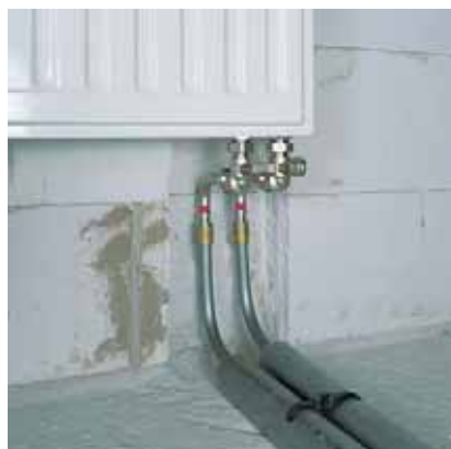
Рис. 150. Подключение к отопительному прибору труб RAUTITAN stabil с помощью Г-образных присоединительных трубок
