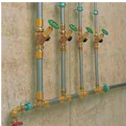
Рис. 114. Система холодного водоснабжения из труб RAUTITAN stabil
