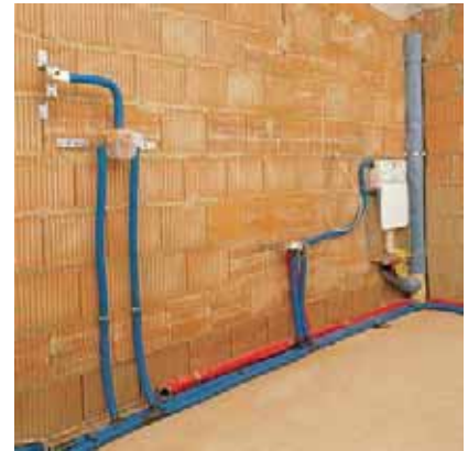
Рис. 126. Трубопроводная разводка в ванной комнате из предварительно изолированных труб RAUTITAN his
