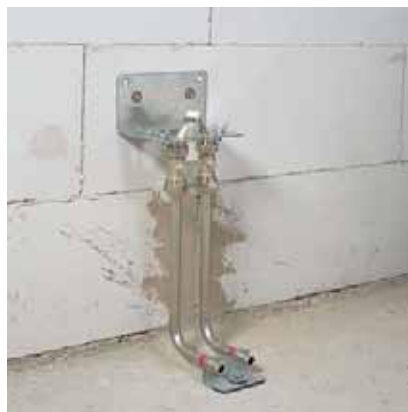
Рис. 166. Монтажный шаблон REHAU при присоединении труб к отопительному прибору „из пола“
