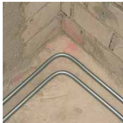
Рис. 132. Исполнение отводов трубами RAUTITAN stabil
