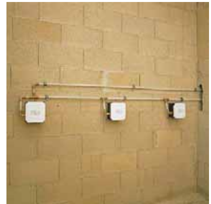
Рис. 127. Подключение душевых смесителей в ряд трубами RAUTITAN his
