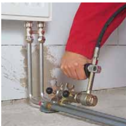
Рис. 142. Присоединить полимерные трубы с помощью подвижной гильзы
