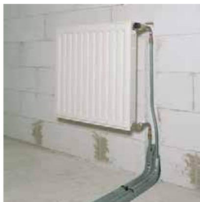
Рис. 151. Боковое подключение к отопительному прибору
