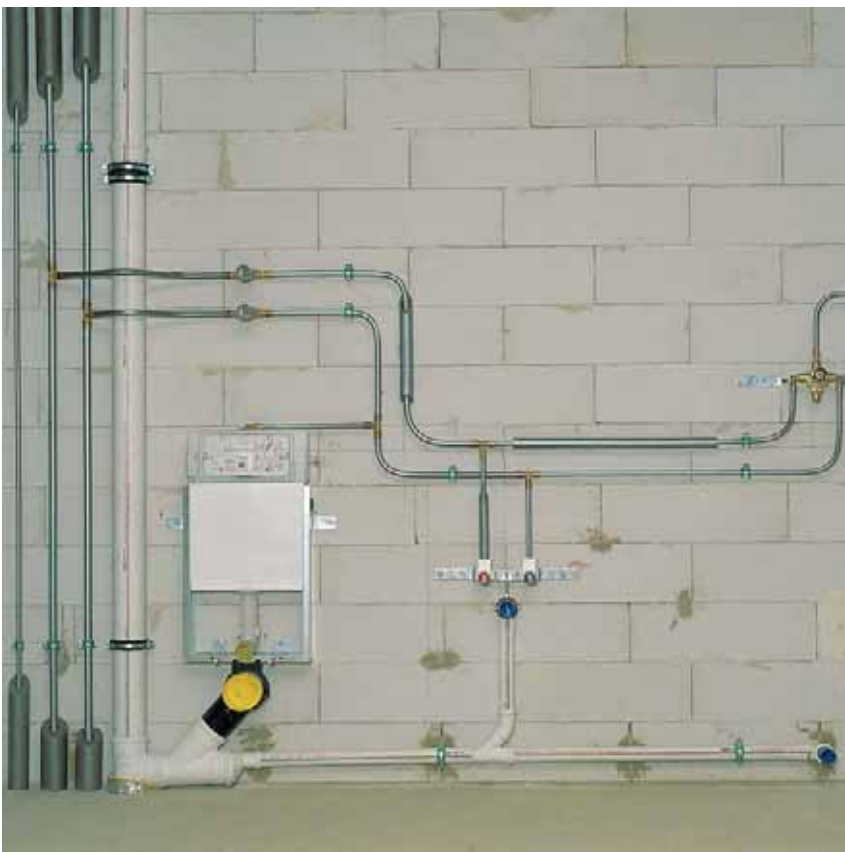
Рис. 118. Поэтажное ответвление стояков из труб RAUTITAN stabil
