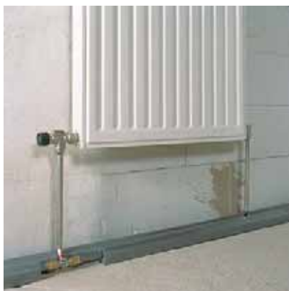
Рис. 144. Разностороннее присоединение с помощью Т-образных присоединительных трубок
