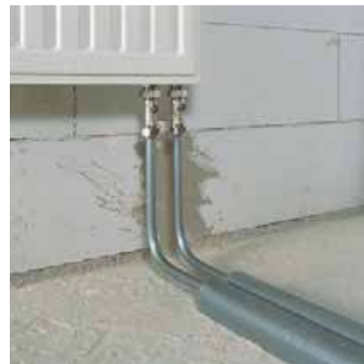
Рис. 145. Непосредственное подключение труб RAUTITAN stabil к отопительному прибору
