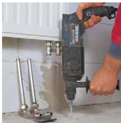
Рис. 140. Просверлить отверстие под дюбель
