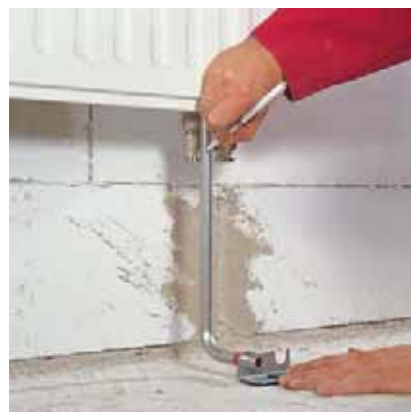
Рис. 136. Отмерить длину присоединительной трубки
