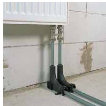
Рис. 146. Непосредственное подключение к отопительному прибору труб RAUTITAN flex, а также отопительных труб RAUTITAN pink с помощью комплекта направляющих трубок
