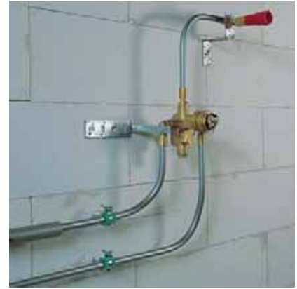
Рис. 119. Присоединение труб RAUTITAN stabil к душевому смесителю
