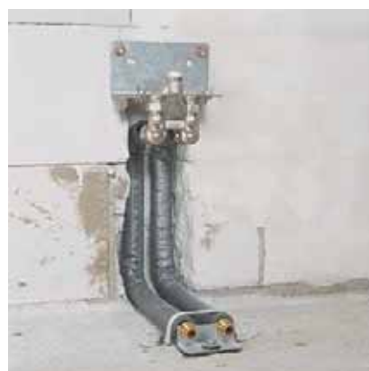
Рис. 167. Монтажный шаблон REHAU при присоединении труб к отопительному прибору „из стены“
