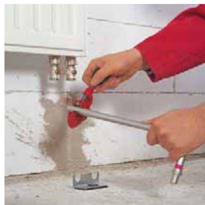
Рис. 137. Обрезать присоединительные трубки на необходимую длину и удалить заусенцы
