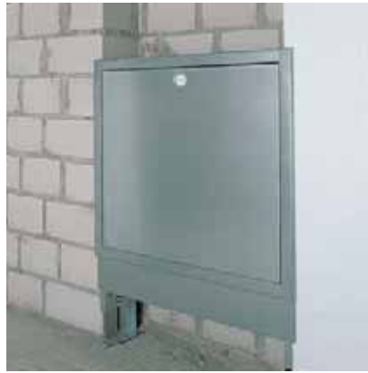
Рис. 162. Вариант встроенного распределительного шкафа
