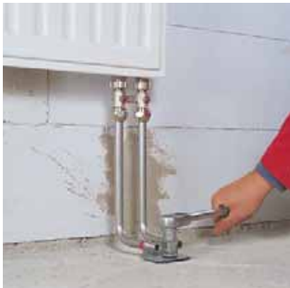
Рис. 141. Крепление фиксирующего уголка
