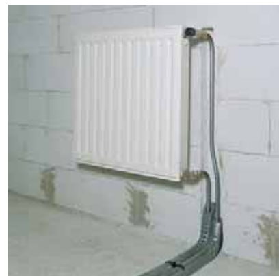
Рис. 153. Непосредственное подключение к вентилям отопительного прибора
