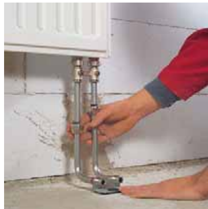
Рис. 138. Надвинуть резьбозажимные соединения на присоединительные трубки
