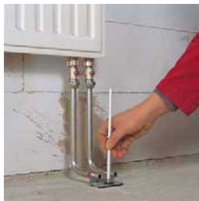
Рис. 139. Отметить место крепления фиксирующего уголка
