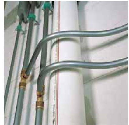
Рис. 120. Развязка трубопроводов различных систем при применении труб RAUTITAN stabil
