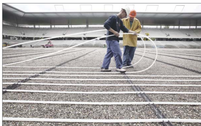
Рис. 9-34 Укладка отопительных труб
