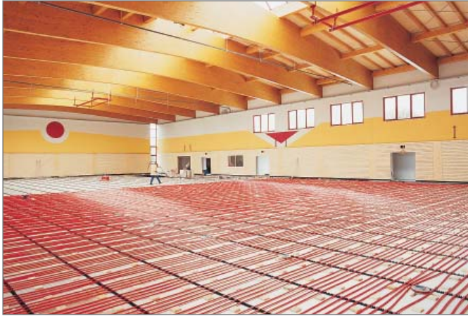
Рис. 9-17 SBH Система со стандартным распределительным коллектором
