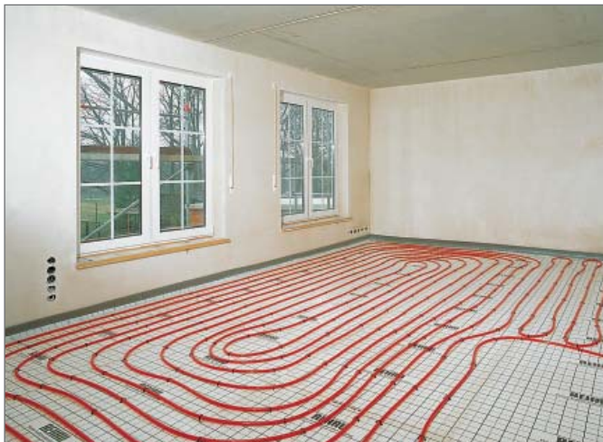
Рис. 3-22 Система крепления труб с помощью гарпун-скоб
