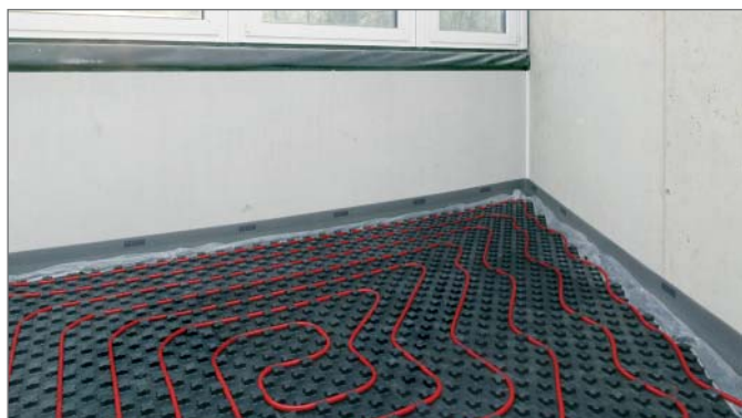
Рис. 3-11 Маты с фиксаторами Varionova с шаго-звукоизоляцией 30-2 снизу
