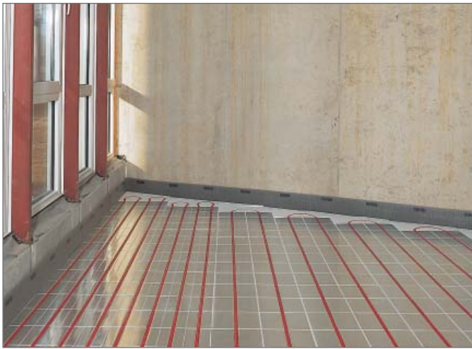
Рис. 3-49 «Сухая» система укладки труб
