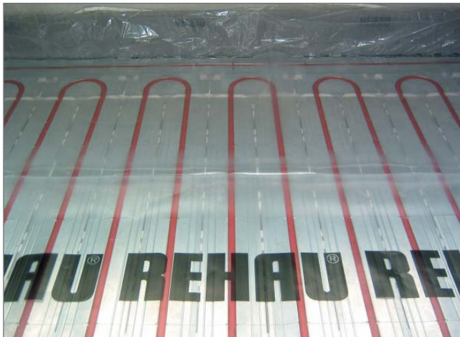
Рис. 3-59 Система укладки труб на теплоизоляционных матах TS-14
