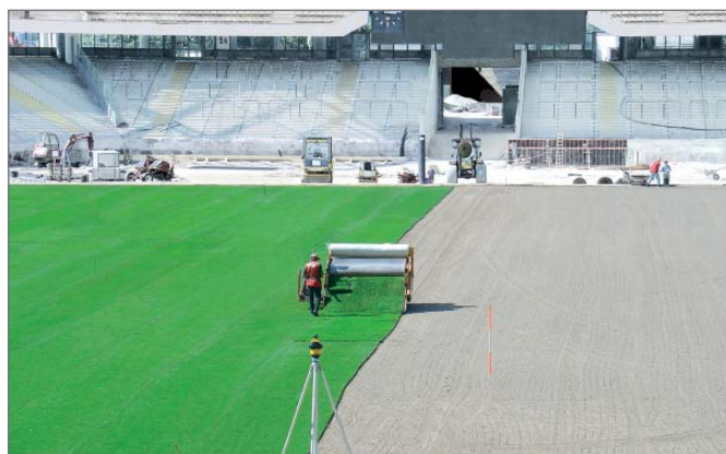
Рис. 9-35 Укладка газона
