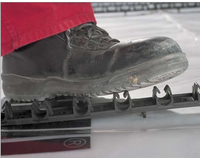
Рис. 3-34 Вдавливание фиксирующих шин RAUFIX в конструкцию пола
