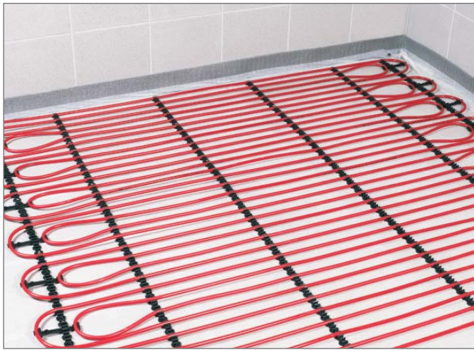
Рис. 3-68 Напольная фиксирующая шина для мокрого способа монтажа
