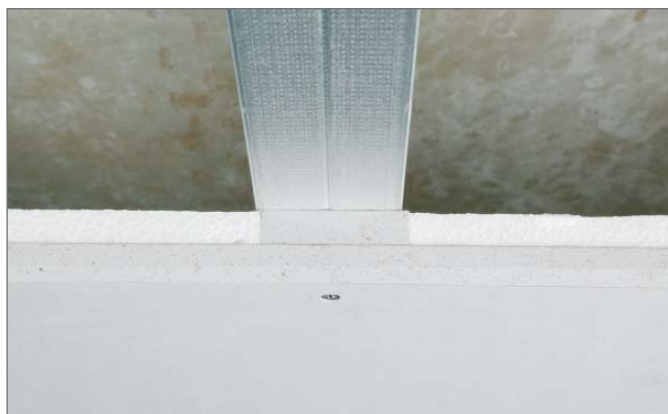
Рис. 4-6 Крепление потолочных панелей
