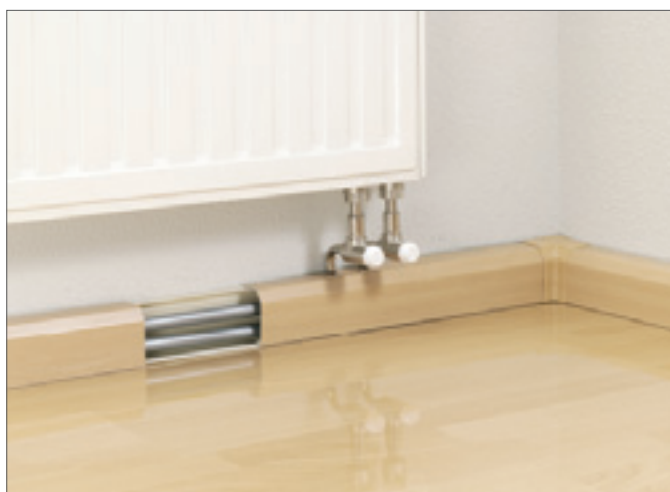
Рис. 4-14 Подключение к радиатору из плинтуса
