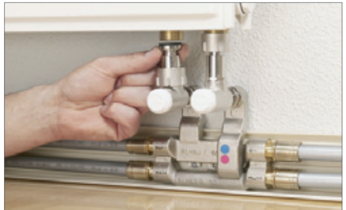
Рис. 18-26 Подключение угловых телескопических резьбозажимных соединений
