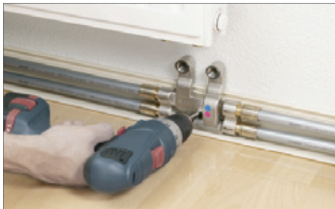
Рис. 18-36 Закрепление крестовины SL-RAUTITAN
