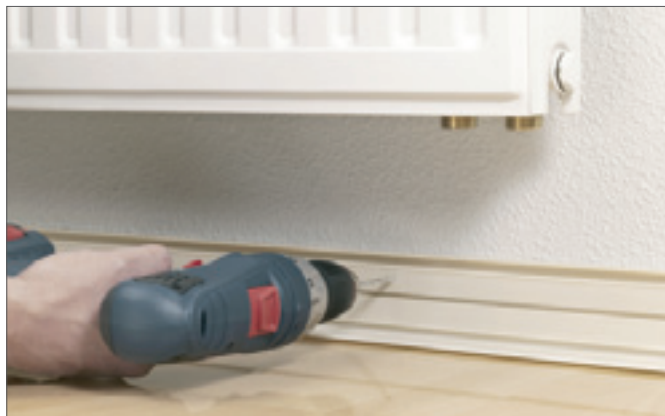
Рис. 18-31 Закрепление основания плинтусного канала RAUSOLO
