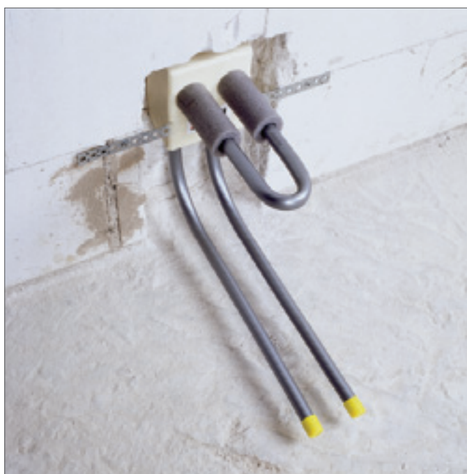
Рис. 4-13 Подключение к радиатору из стены
