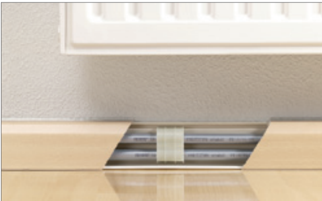
Рис. 18-24 Фиксация труб отопительной системы в плинтусном канале RAUSOLO
