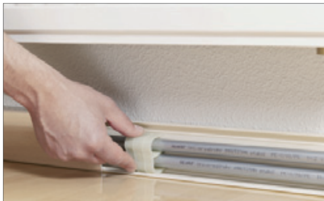
Рис. 18-37 Установка фиксаторов труб отопительной разводки
