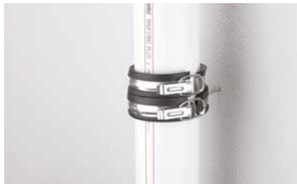
Рис. 86 Шумопоглощающий хомут в смонтированном состоянии
