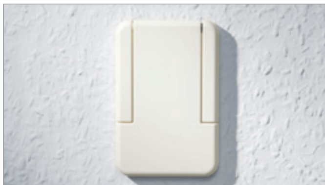
Рис. 5-5 Полностью смонтированная всасывающая розетка (радиуправление)
