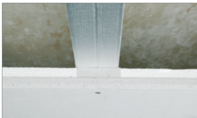
Рис. 3-06 Крепление потолочных панелей
