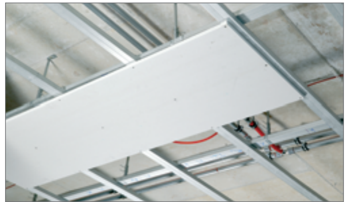
Рис. 4-05 Стеновая панель обогрева/охлаждения, смонтированная на потолке
