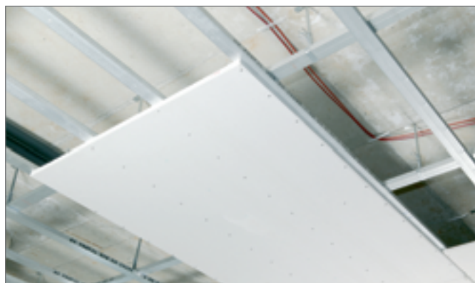
Рис. 3-05 Смонтированный потолочный элемент
