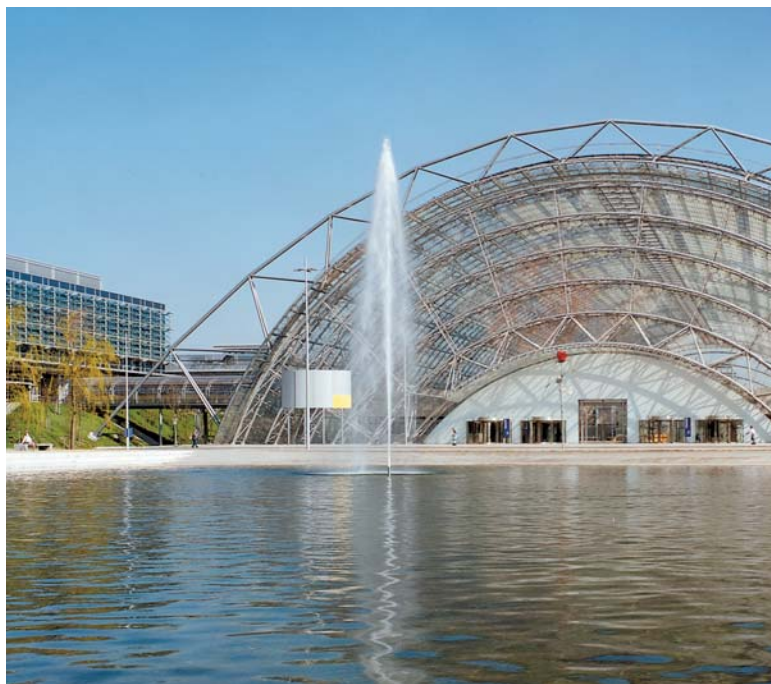
Выставка в Лейпциге: система оснащена установкой поддержания давления reflex 'gigamat'
