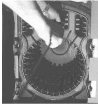
Рис. 15 очистка котла с помощью щетки
