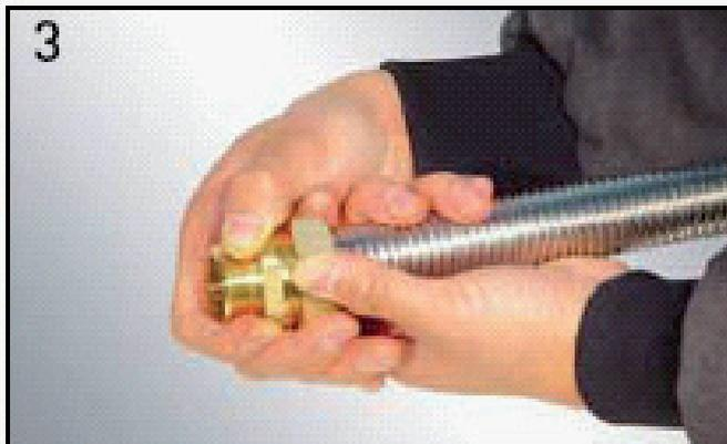
Резьбовые приемные части уплотнить посредством синтетического капронового шнура с герметизирующим составом либо любым другим сантехническим уплотнителем для трубной резьбы.
