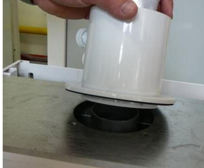
**Шаг 1 – снять из горловины вентилятора диафрагму для увеличения длины**
