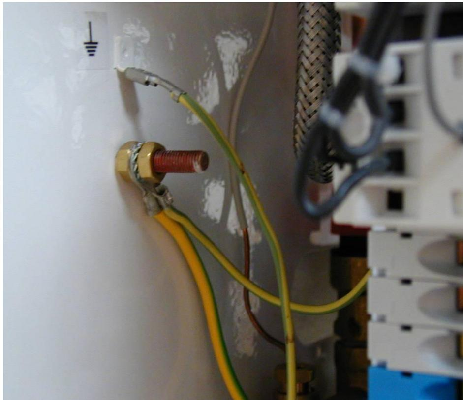
Система отопления должна быть защищена от опасности получения травм посредством воздействия электрического тока токопроводящими соединениями !
