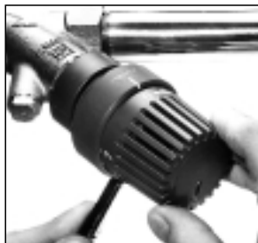
Рис. 12: Снять маховик при помощи инструмента (арт.- № 198 91 00) или штифта, например, кнопкой автотручки. При этом штифт вставить в демонтажное отверстие на нижней стороне термостата. При повороте маховика в положение отключения он может быть легко снят.
