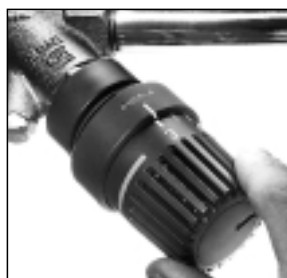
Рис. 15: Маховик надеть обратно так, чтобы цифра „3” находилась против указателя настройки. Нажать рукой на маховик с усилием так, чтобы он вошел в держатель.
