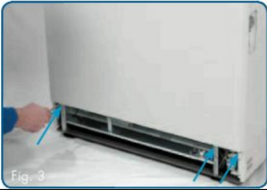
Извлечь 3 винта передней панели.
